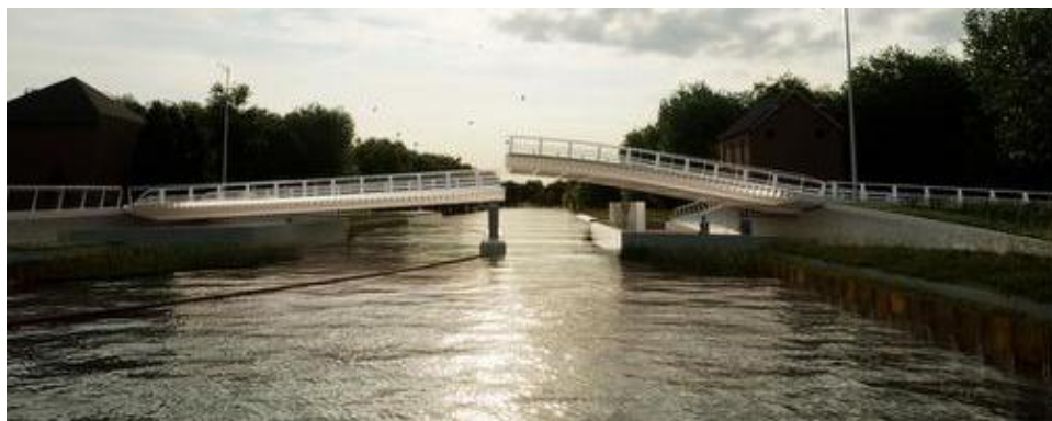
Le futur Pont Capitte sera partiellement mobile, pour céder le passage aux bateaux de plaisance. © SBE
